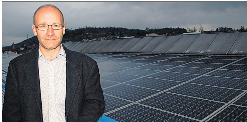
ENERGIE VOM DACH Martin Kleiner, Geschäftsleiter der O. Kleiner AG, zeigt die neue Photovoltaikanlage auf dem Produktionsgebäude seines Unternehmens. FABIAN HÄGLER
