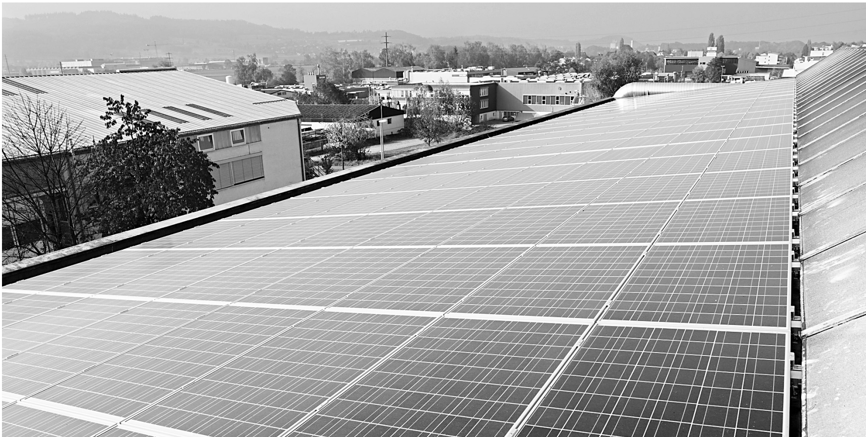
Strom für sieben Haushalte: Jeder verfügbare Quadratzentimeter Dachfläche der O. Kleiner AG wurde ausgenutzt, um die dritte und bisher grösste Fotovoltaikanlage der IBW Energie AG zu bauen. Die Hälfte des Stroms, rund 15000 Kilowattstunden, nimmt die O. Kleiner gleich selber ab.
